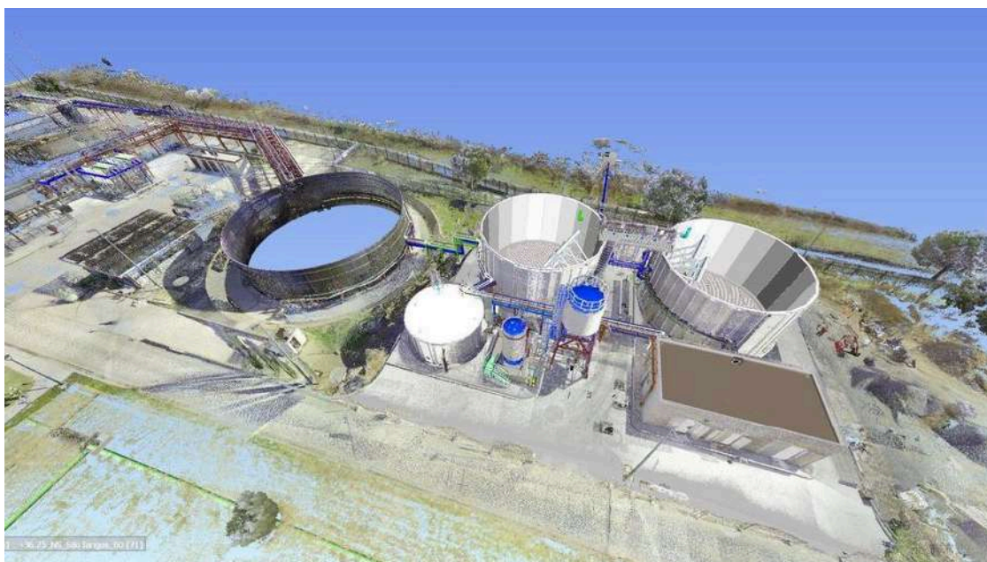
Ampliación de la estación depuradora de aguas residuales industriales de Heineken (EDARi) de Sevilla / Aqualia
