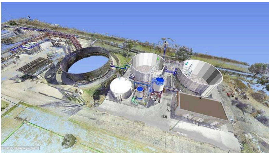
Ampliación da estación depuradora de augas residuais industriais de Heineken (EDARI) de Sevilla
