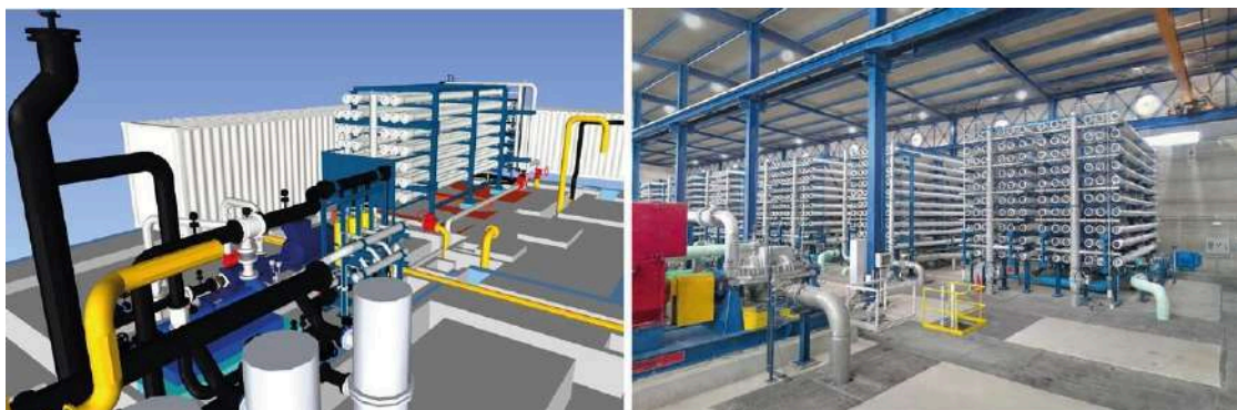
Remodelación Estación Desaladora de Agua de Mar EDAM de Gran Tarajal Fuerteventura
