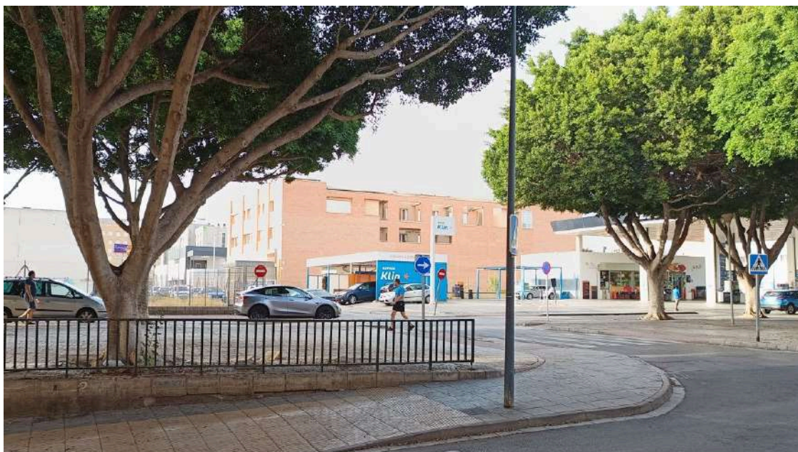
Calle Olula con calle Las Alpujarras, zona en la que se ejecutarán los trabajos de mejora de la red de abastecimiento. Francisco G. Luque
